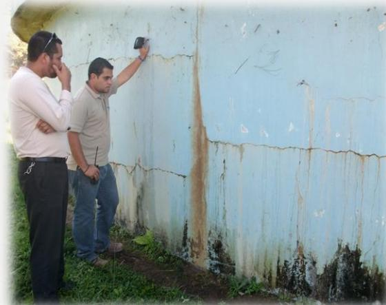
**Fotografía 6.1** Panorámica de la situación de la estructura del tanque Jaime Rosenthal Oliva 200,000 galones; la estructura tiene fugas de agua debido a que la pared tiene fisuras (filtraciones). OPS/OMS, 2012.
