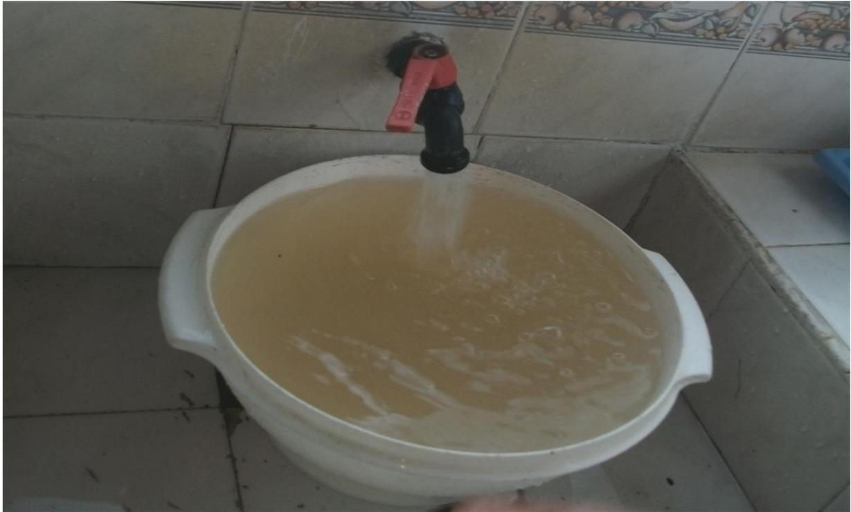
**Fotografía 6.5** Durante la visita a las viviendas a la colonia Las Colinas N.1 se observo que las estructuras de almacenamiento sirven como sedimentadores, debido que el agua llega con mucha turbiedad y sedimento, 2012.
