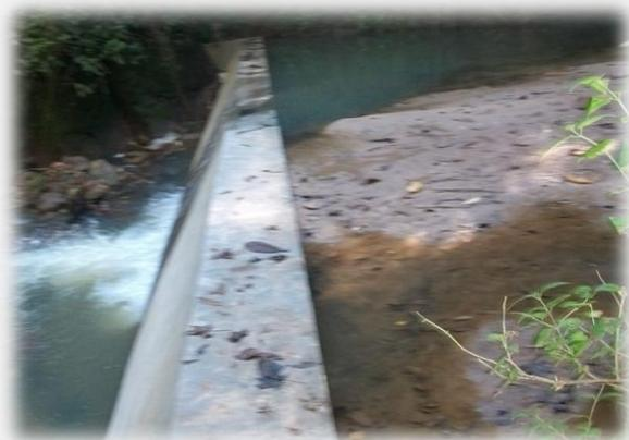
**Fotografía 6.1** En la represa de captación de El Tablón muestra la cantidad de sedimentación que se genera en tiempo de invierno por la crecida del río Calan (izquierda) y lo mismo se observa en la presa de sedimentación de El Tablón. OPS/OMS, 2012.
