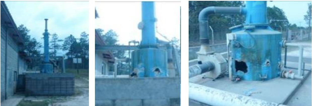
Para controlar esta fuga de cloro se requirió la presencia del Cuerpo de Bomberos para atender la emergencia. Esta fuga provocó la corrosión de ciertos equipos y daño la computadora donde se encuentra el Sistema SCADA, por lo que la Planta está inoperable en opción automática.
