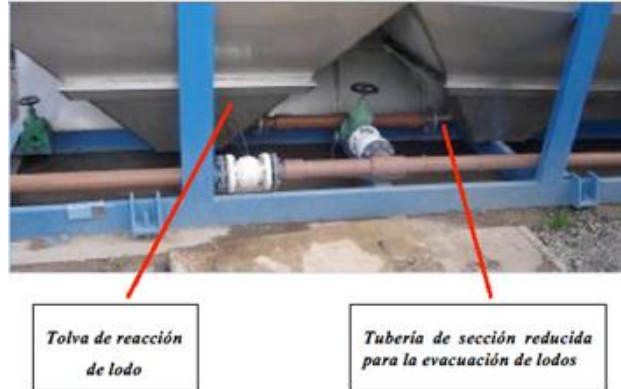
Fotografía 23 Tolva de Reacción de Lodo
