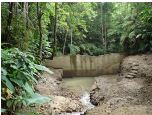
Fotografía 5 Presa de Captación, El Tablón
