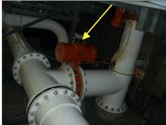
Fotografía 19 Válvula Automática
