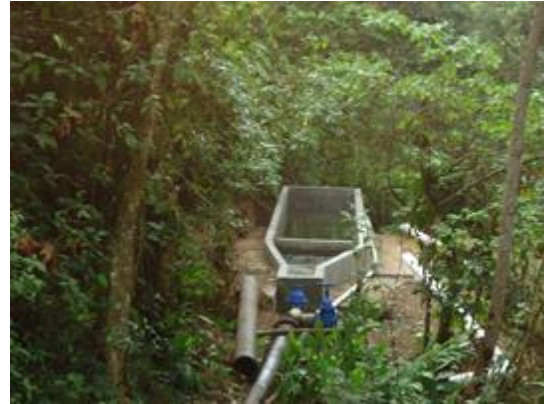
Fotografía 4 Desarenador, La Porra
