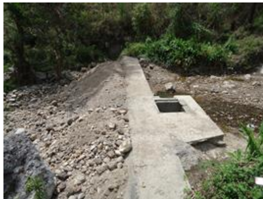
Fotografía 1 Presa de Captación, Guaratoro
