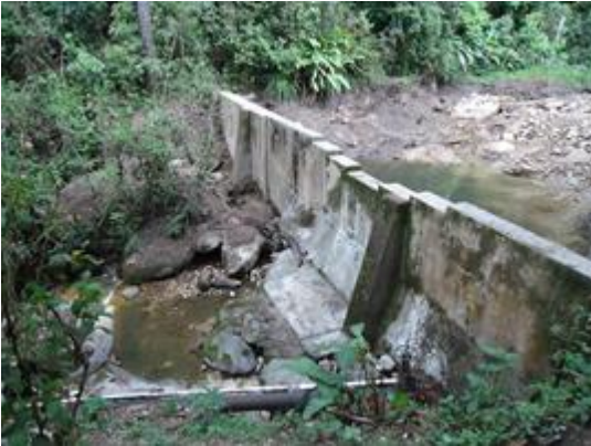
Fotografía 3 Presa de Captación, La Porra
