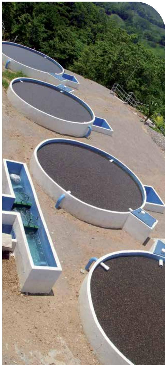
Foto: Filtro ascendente. Planta de filtración de agua múltiples etapas (FIME), Puerto Cortes. Archivo Cooperación Suiza.
