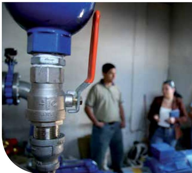
Foto: Válvula de paso instalada en un sistema de baja presión para controlar el flujo de agua. Colonia Villa Franca, Tegucigalpa. Francisco Morazán. Archivo del Banco Mundial.
